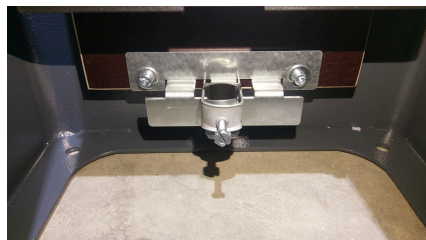
Abbildung 5.2: Beispiel für eine PUK-Zugentlastung
