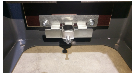
Abbildung 5.2: Beispiel für eine PUK-Zugentlastung
