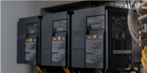
Mit den Frequenzumrichtern von Mitsubishi Electric reinigt die Waschanlage von BHB besonders energieeffizient.
