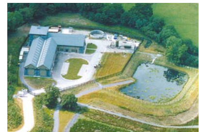
Ejemplo de una estación de bombeo difícilmente accesible.
