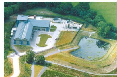
Station de pompage isolée.
