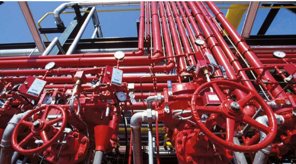
Systèmes industriels de pompage : exemple d'application des variateurs de fréquence FR-F800
