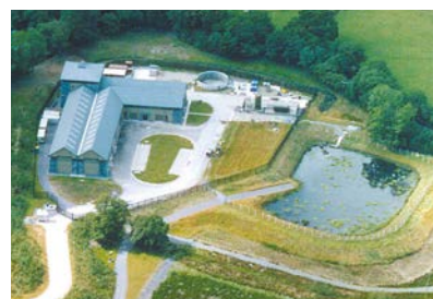
Applicazione in una stazione di pompaggio remota.
