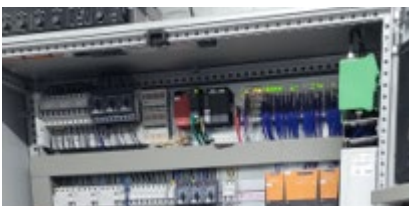
Bild 6: Das Steuerungssystem MELSEC System-Q SPS verwaltet alle Simulator Funktionen
