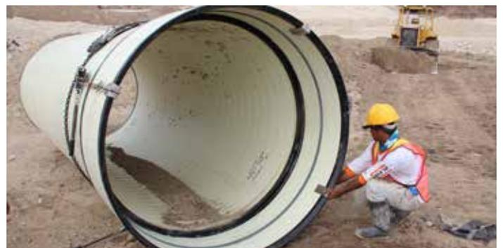
Para lograr el acople entre tubo y unión se puede utilizar maquinaria tipo retroexcavadora protegiendo el caucho y el extremo del tubo con cuartones.
