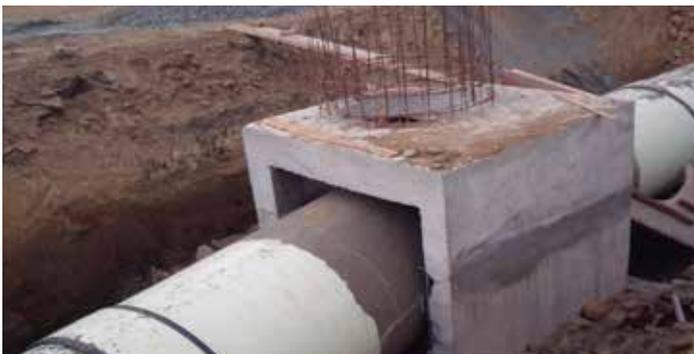
Para empatar el tubo Novaloc al pozo de revisión o a estructuras de hormigón se lo deberá acondicionar, esto es: Lijar con lija grano fino, colocar Kalipega y espolvorear arena seca en la superficie de contacto en el hormigón.
