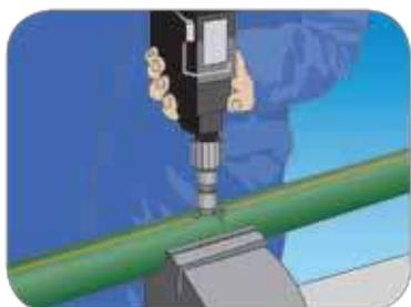
**2.-** Colocar el perforador adecuado para la montura de derivación en el taladro y completar la perforación.
