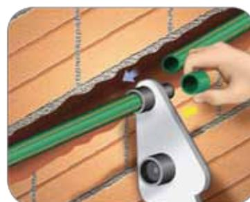
**3.-** Saque el tubo hacia afuera de la canaleta de la pared. Introduzca simultáneamente en el tubo la boquilla hembra del termofusor y la cupla en la boquilla macho. Espere el tiempo necesario, conforme a la tabla de tiempos de termofusión e introduzca la cupla en el tubo caliente.
