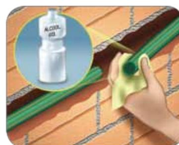
**2.-** Limpie con alcohol la superficie externa que será termofusionada.
