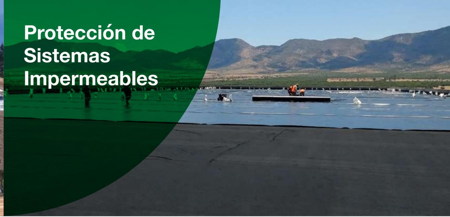
Las prácticas de la minería requieren de un alto desempeño en los sistemas de revestimiento para contención de líquidos u otros fluidos, lo cual se logra a través de la utilización de Geomembranas y GCL (Geosynthetic CLAY LINER), con el fin de proteger los recursos subterráneos y el nivel freático del suelo para evitar su contaminación, se utilizan en la recuperación de productos químicos.
