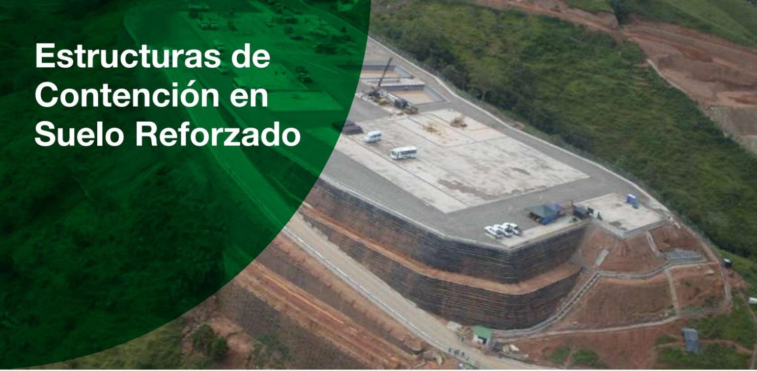
Las Estructuras de Contención en Suelo Reforzado permiten la construcción y el refuerzo de terraplenes y muros autoportantes que **garantizan los criterios de seguridad y estabilidad del proyecto a mediano y largo plazo.**
