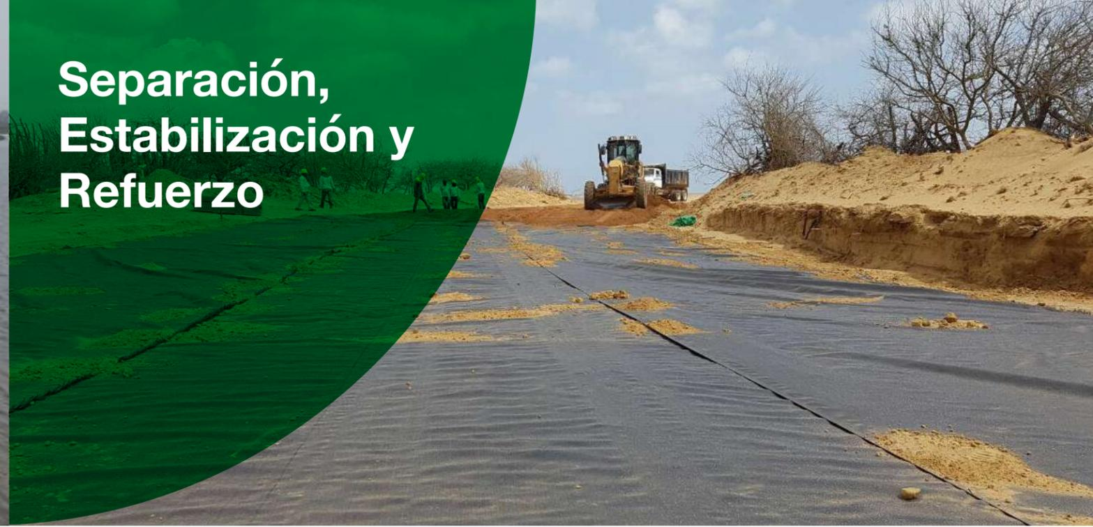
Es un sistema flexible desarrollado a partir de la combinación apropiada de Geosintéticos. **Permite la generación de áreas planas, mediante la ampliación, recuperación o construcción de espacios en terrenos montañosos o en presencia de cuerpos de agua.** Es una solución perdurable en el tiempo ya que cuenta con protección para el control de erosión.
