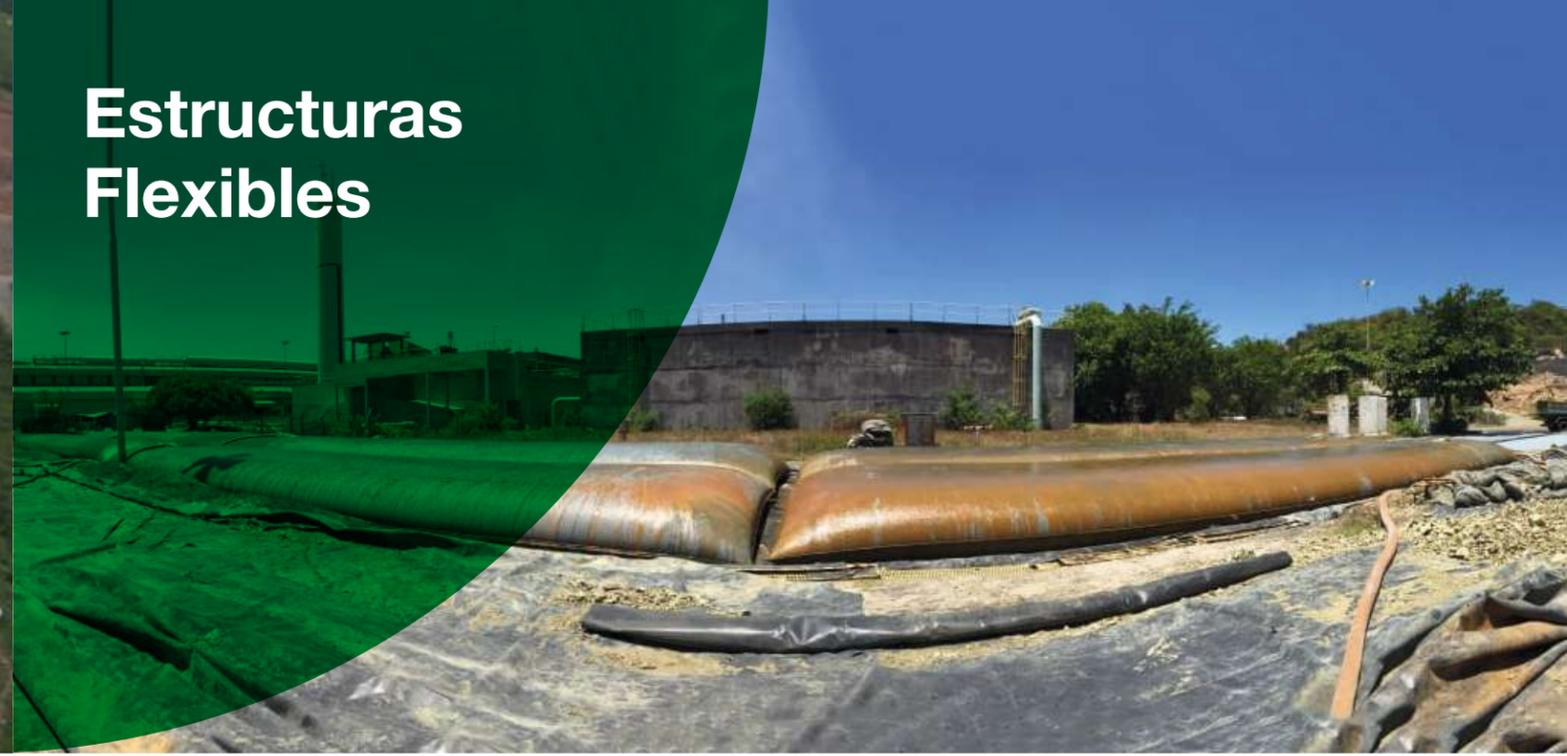
Las Estructuras Flexibles son geoformas de diferentes dimensiones fabricadas con Geotextiles Tejidos de alto desempeño, que **se adaptan a las condiciones especiales de cada proyecto.** Estas estructuras se pueden llenar con distintos materiales disponibles en la obra y se pueden instalar en condición seca o sumergida. La dimensión y tipo de estructura dependen de su aplicación, proceso constructivo y clase de proyecto. Las alternativas de solución que ofrecemos son:
