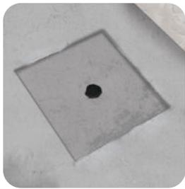
Preparar a laje para o recebimento da placa metálica, através da abertura de um furo central e o rebaixamento da laje (opcional).
