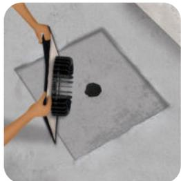
**Passo 1:** Acoplar a chapa metálica no bocal e após isso, aplicar uma camada de manta asfáltica de impermeabilização embaixo da chapa. Garanta que a manta esteja aplicada em toda a seção da chapa metálica.
