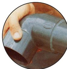
6.- Una el tubo con la conexión asegurándose de un buen asentamiento y dele un cuarto de vuelta para distribuir la soldadura; mantenga firmemente la unión por 30 segundos.
