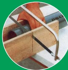
1.- Corte el tubo con una segueta. Asegúrese que el corte esté a escuadra usando una caja de guía.
