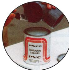
5.- Aplique una capita de soldadura líquida en el interior de la campana de la conexión
