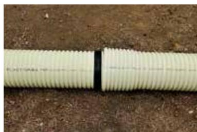
Coloque el caucho en dos valles consecutivos del extremo del tubo hasta 440mm de diámetro, en correspondencia con la parte lisa de la campana, a partir de 540 el anillo de caucho se alojará a partir del primer valle, asegúrese que quede firmemente asentado. Aplicar generosamente lubricante vegetal sobre el lomo del caucho.
