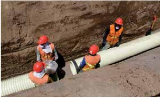
NOVAFORT PLUS es una tubería liviana que se puede manejar fácilmente en obra por cuadrillas pequeñas y hace innecesario el uso de equipo pesado en su manejo e instalación.
