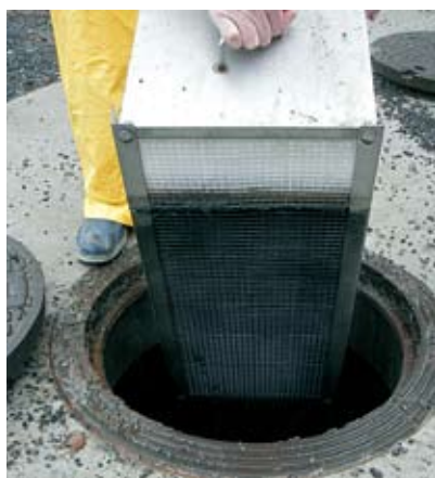
Iebūvēto bloku iespējams noņemt, lai veiktu tā apkopi.
