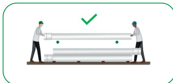
Para não dificultar / impedir a operação de união das pontas com as bolsas dos tubos, ou até mesmo comprometer a estanqueidade do sistema, não arraste ou bata as extremidades dos tubos contra o chão ou outra superfície rígida.
