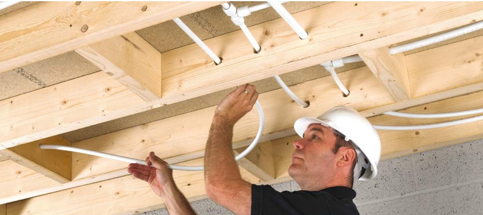
**Het Hep2O leidingsysteem combineert de zeer flexibele PB buizen met handige push-fit fittingen. Met dit systeem legt u zeer snel en gemakkelijk een heet- en koudwaterleidingsysteem aan. Dankzij de volle doorlaat van de fitting kent het Hep2O systeem weinig stromingsweerstand.**
