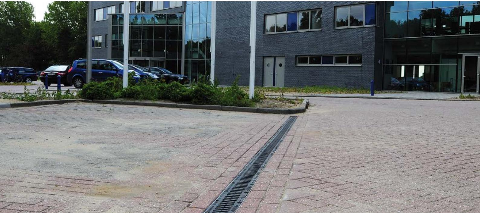
Bij lijnafwatering wordt een gedeelte van de ondergrondse riolering vervangen door afvoergoten. Door het gebruik van deze lijnafwateringsgoten kan neerslag gemakkelijk wegstromen en worden grote, hinderlijke hoeveelheden water op straat voorkomen.
