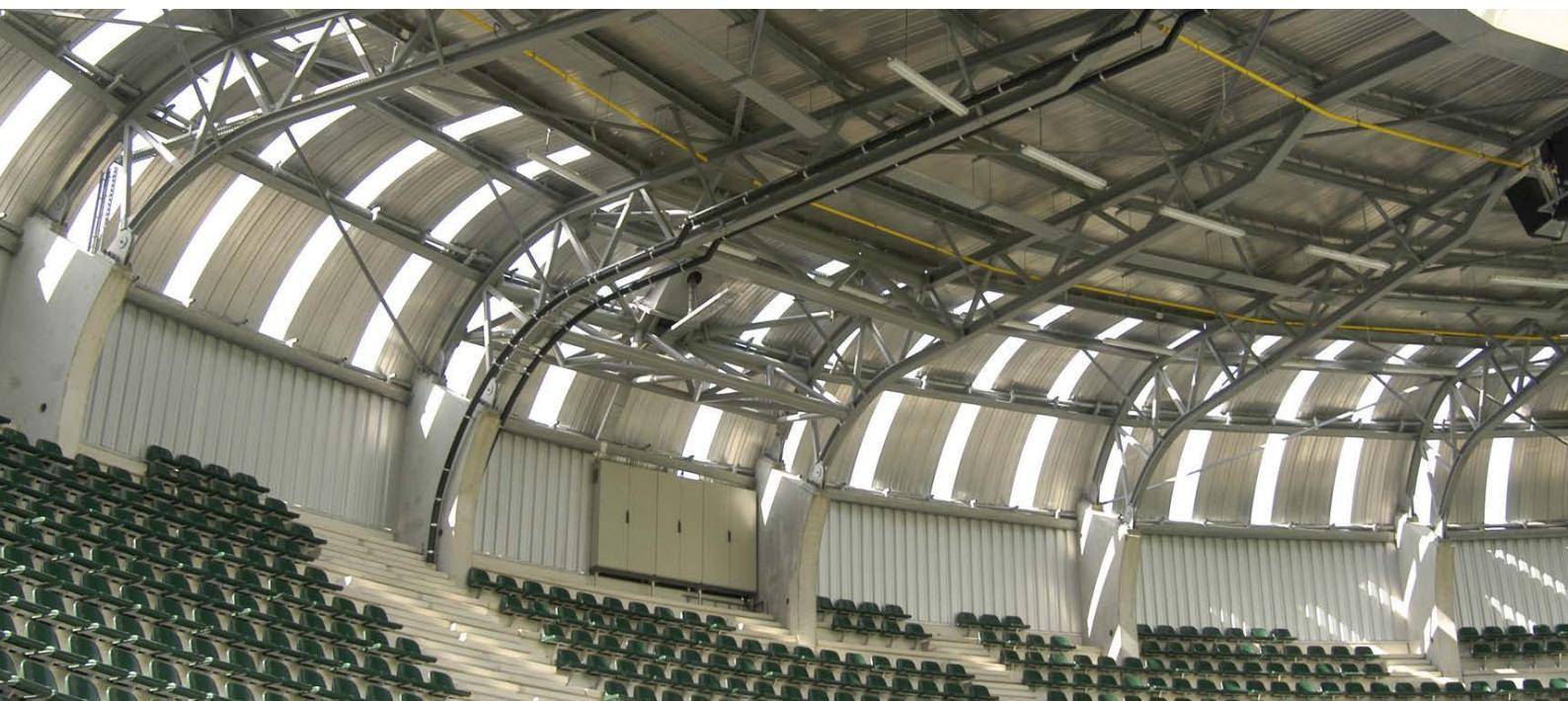
**Het Wavin QuickStream volvulsysteem garandeert een snellere waterafvoer van grote dakoppervlakken met gebruik van kleine leidingdiameters.**
