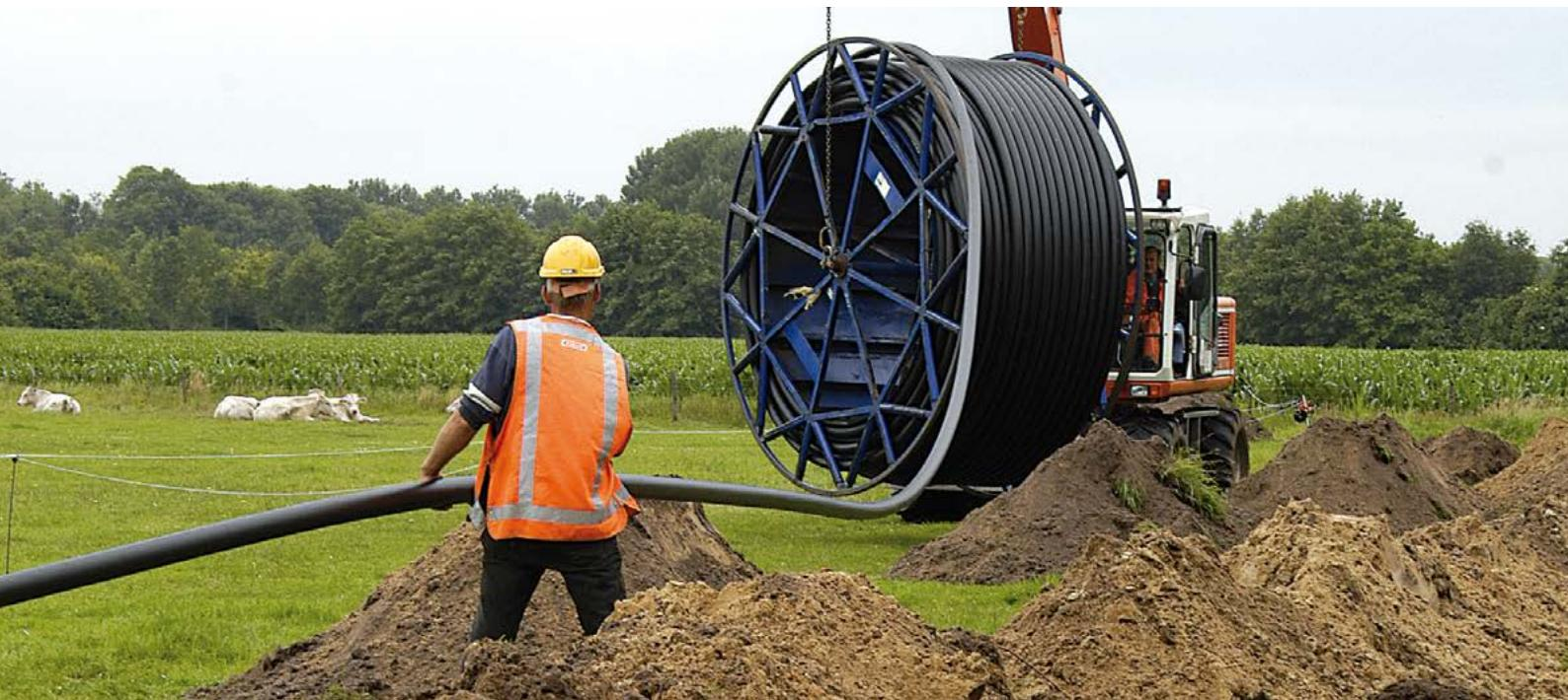
**PE drukleidingen worden toegepast voor het onder druk transporteren van gas, drinkwater, -en afvalwater. PE staat voor Polyetheen en is een kunststof die beschikt over uitstekende eigenschappen; het is volledig corrosievrij en laag in gewicht ten opzichte van traditionele materialen.**
