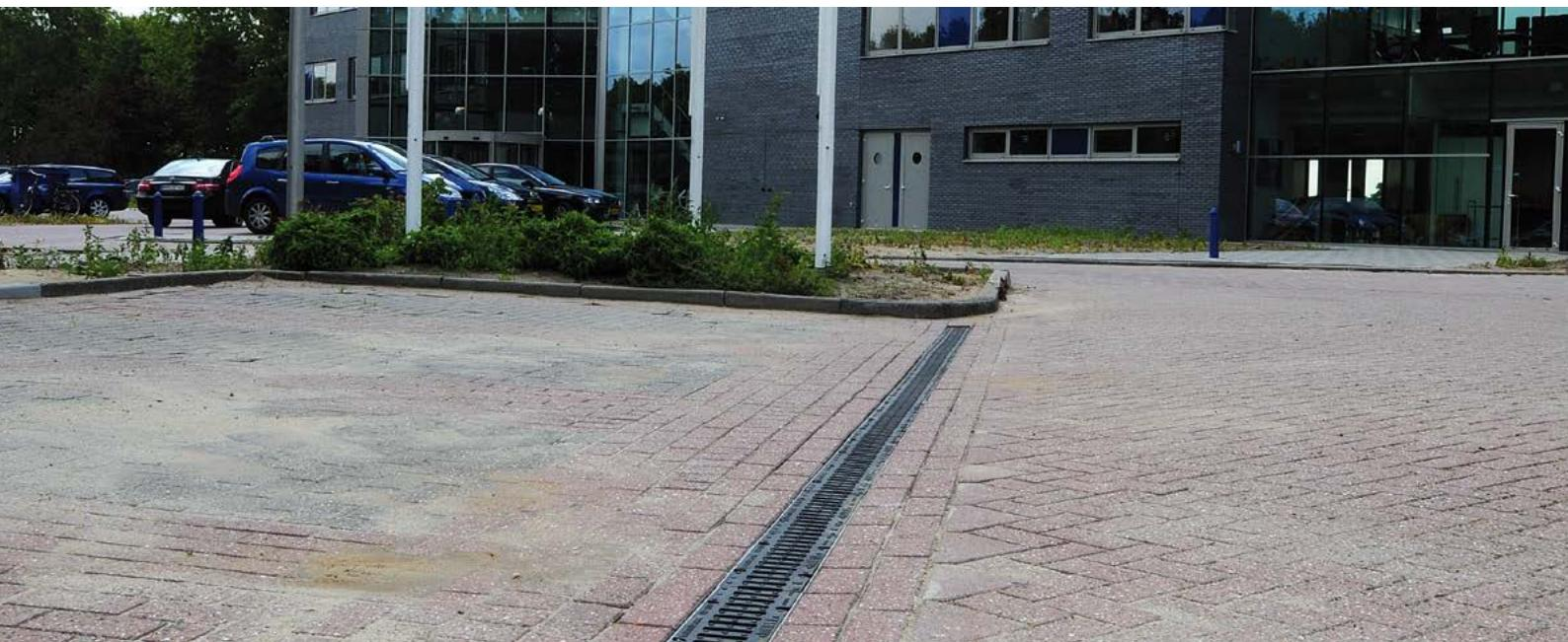
Bij lijnafwatering wordt een gedeelte van de ondergrondse riolering vervangen door afvoergoten. Door het gebruik van deze lijnafwateringsgooten kan neerslag gemakkelijk wegstromen en worden grote, hinderlijke hoeveelheden water op straat voorkomen.
