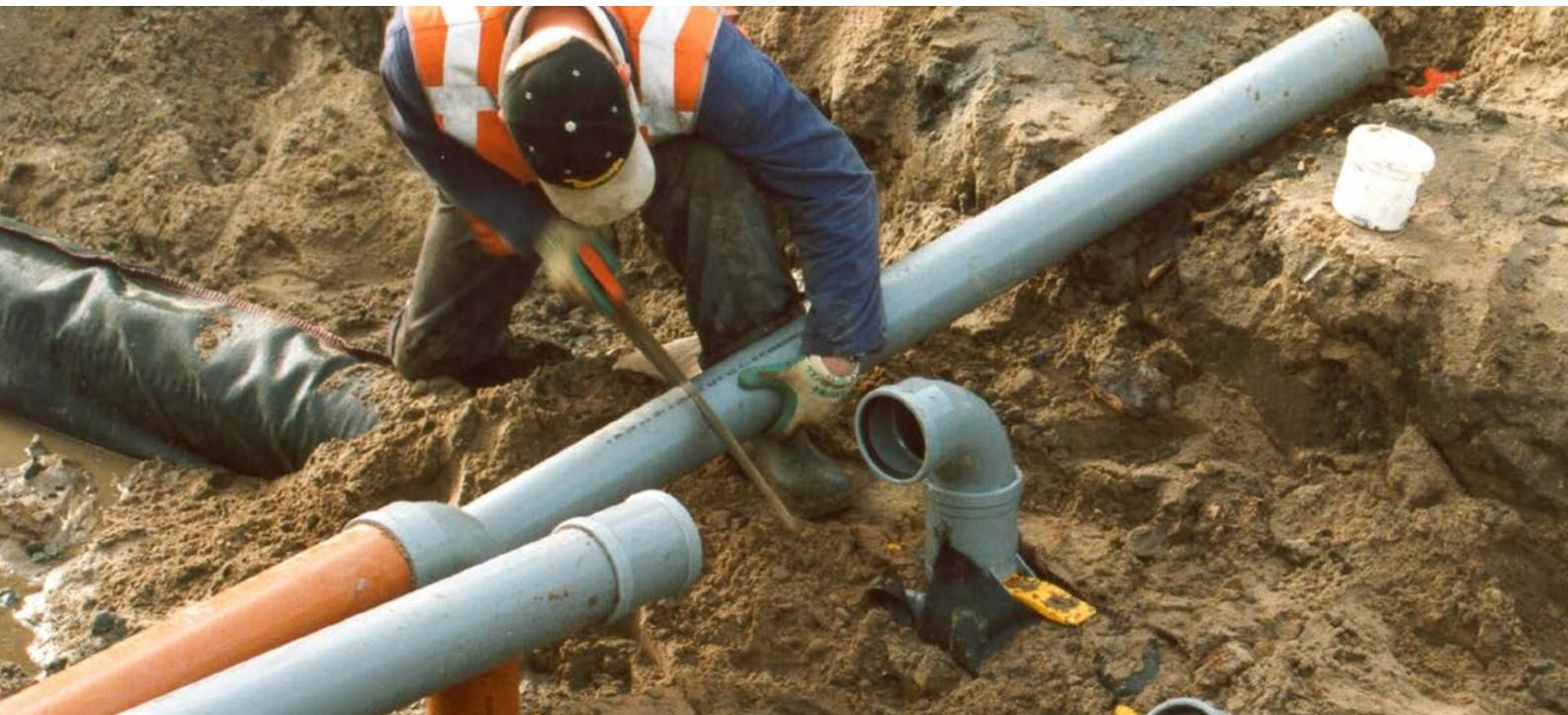
Wavin voert een compleet PVC assortiment buitenriolering. Met PVC als materiaal verkrijgt men een gladwandig, flexibel en volkomen waterdicht leidingsysteem. PVC is bovendien zonder meer bestand tegen alle stoffen die in huishoudelijk afvalwater voorkomen. Door het werken met een licht materiaal, grote buislengtes en steekverbindingen is een zeer snelle plaatsing gegarandeerd.
