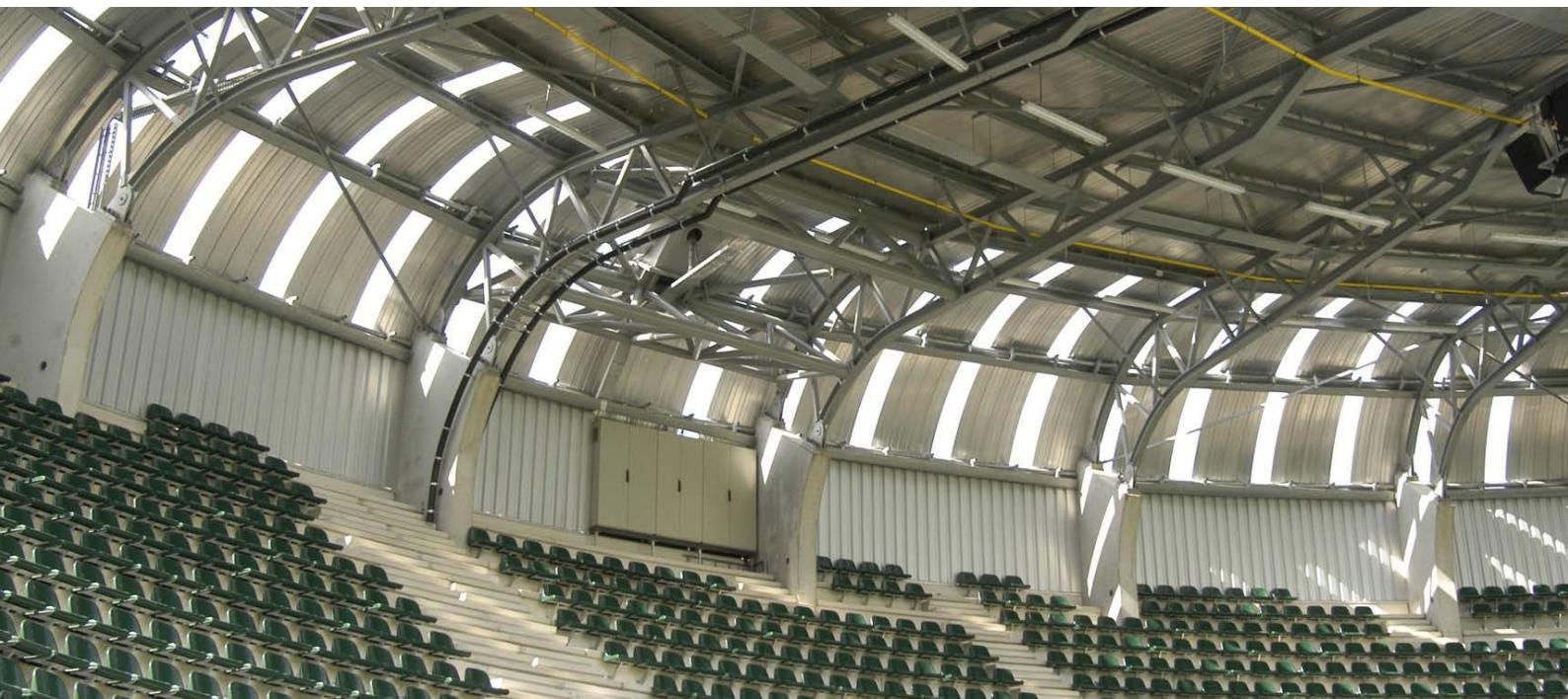
**Met QuickStream kunt u de hevigste regenval met gemak aan. Dit systeem is de aangewezen oplossing voor regenwaterafvoer op complexe daken van grotere gebouwen. Dankzij leidingen met een kleinere diameter bespaart u op bouwruimte en op installatiekosten.**
