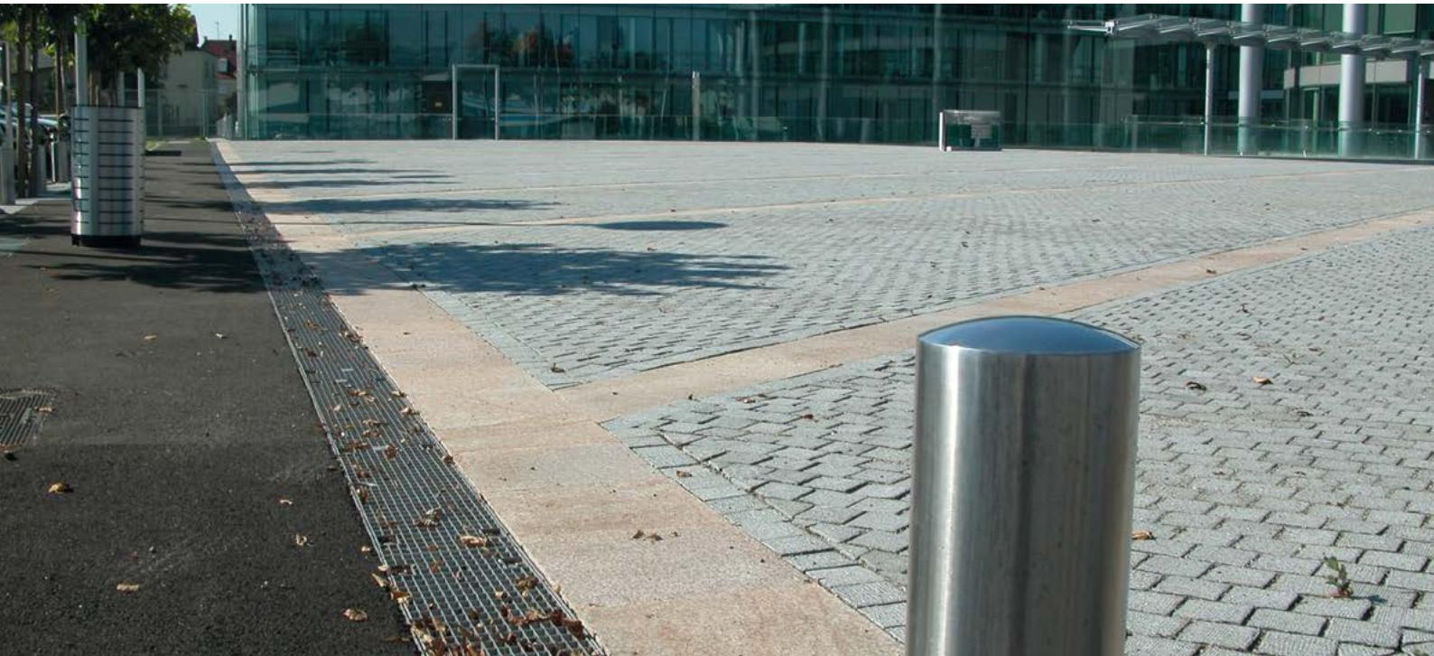
18. Afvoergeulen in beton
