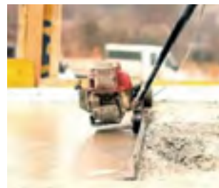
Bezsaluzott öntött betonfödém és a betonozás utáni vibrálás
