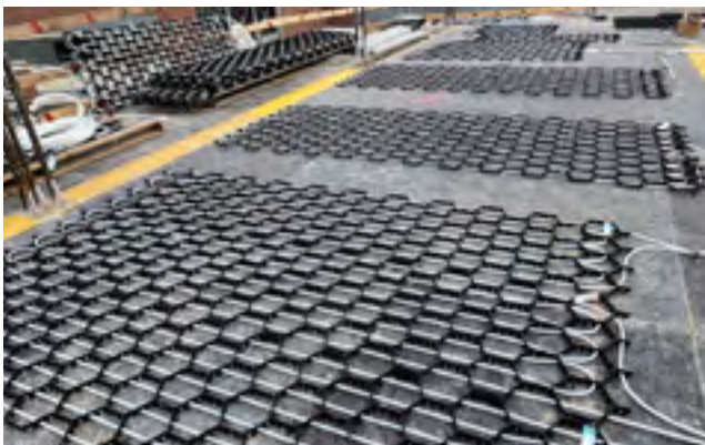
Födémzsaluzatra fektetett Wavin CW-90 regiszter panelek
