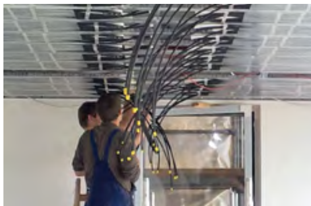
A hűtőmennyezeti panelek csatlakoztatása a gyűjtővezetékkel
