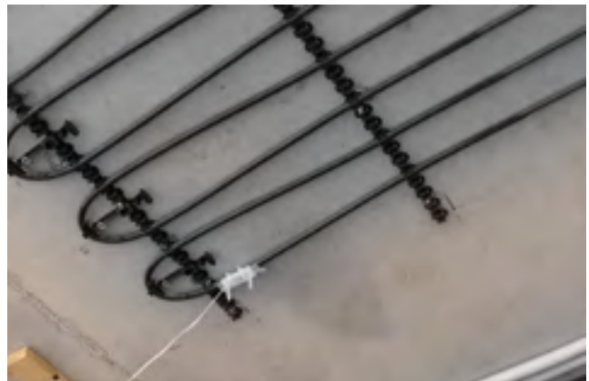
Készre szerelt mező a felszerelt csőfordító idomokkal
