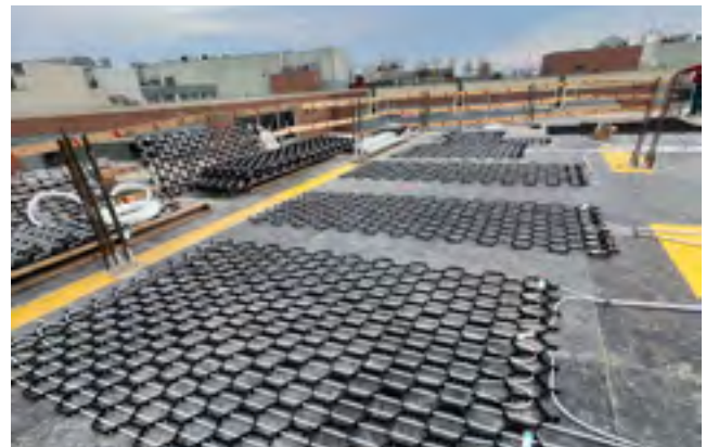
A helyi igényhez hozzáigazított CW-90 panelek
