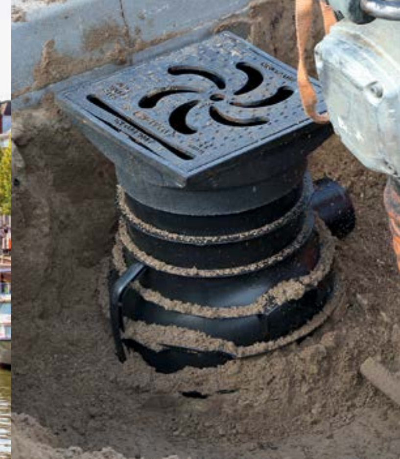
Instalación del sumidero Tegra
