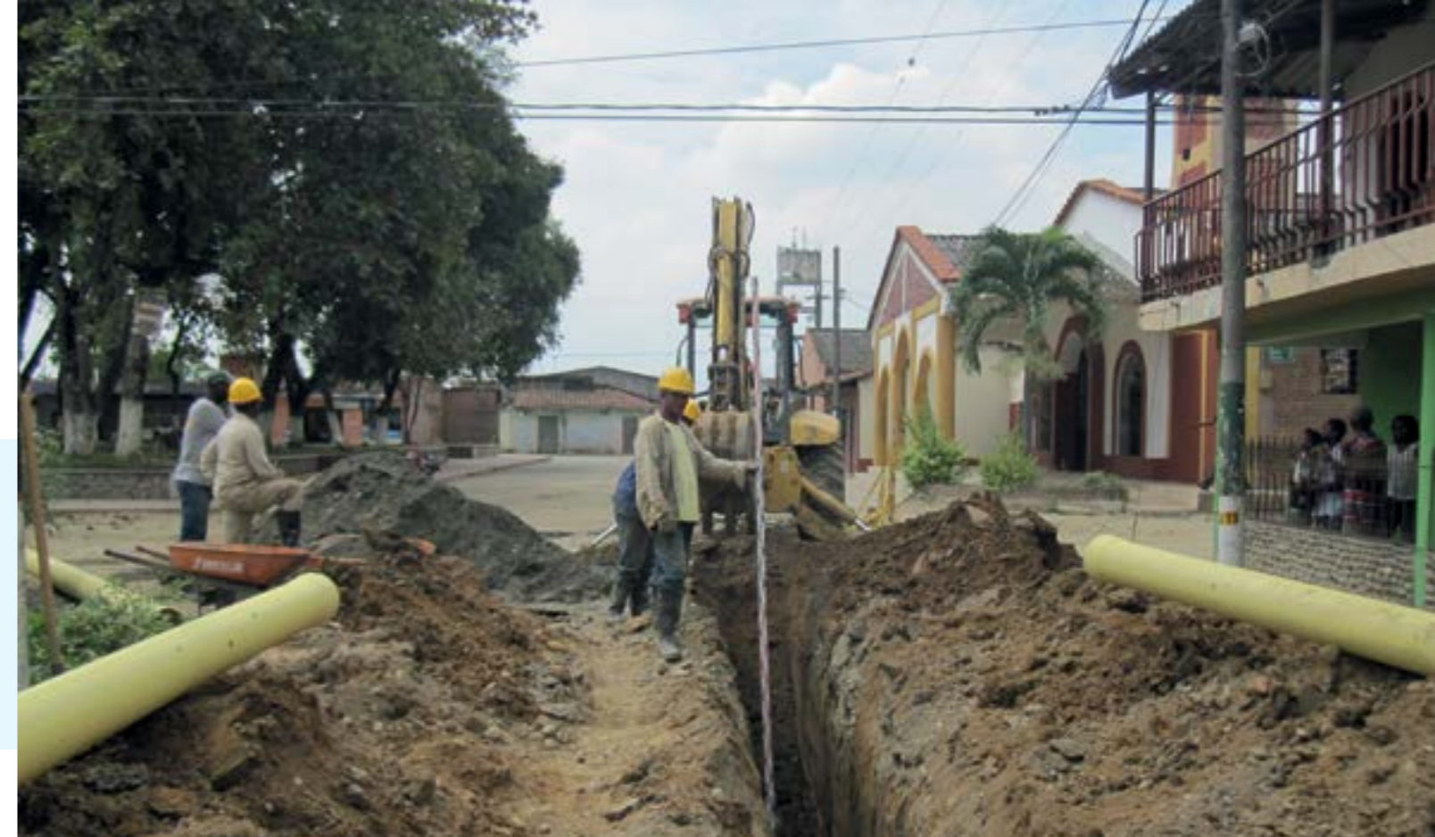
Construcción del sistema de aguas residuales en Guachené
