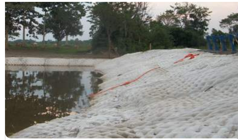
▲ Protección de estructuras hidráulicas.
