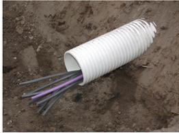
problemas de oxidación y de suelos electrónicos que producen daños en los ductos convencionales de concreto, debido a que el PVC es resistente a los ácidos, a los productos alcalinos y al agua salada.
