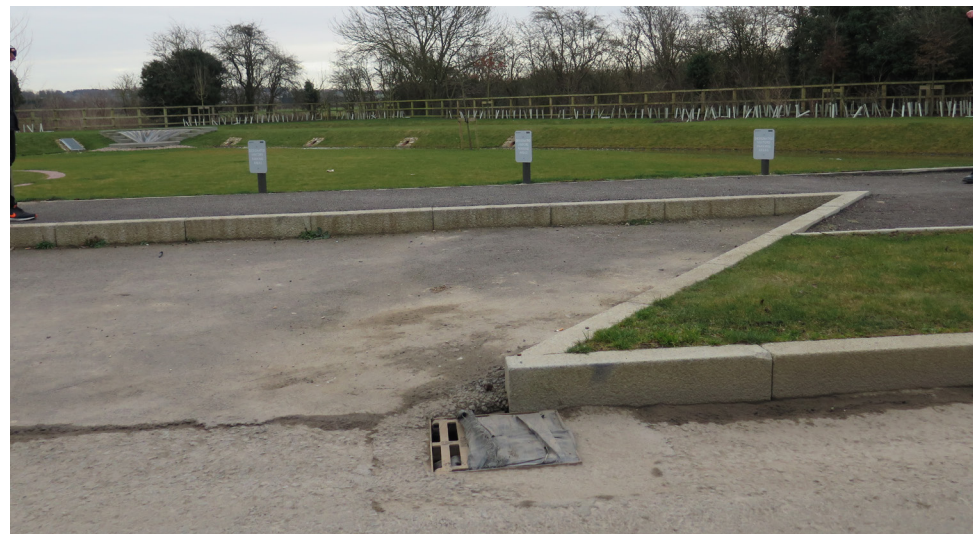
Algengt er að breitt sé yfir lausnir til að koma í veg fyrir skemmdir vegna jarðvegssöfnunar á framkvæmdatíma
