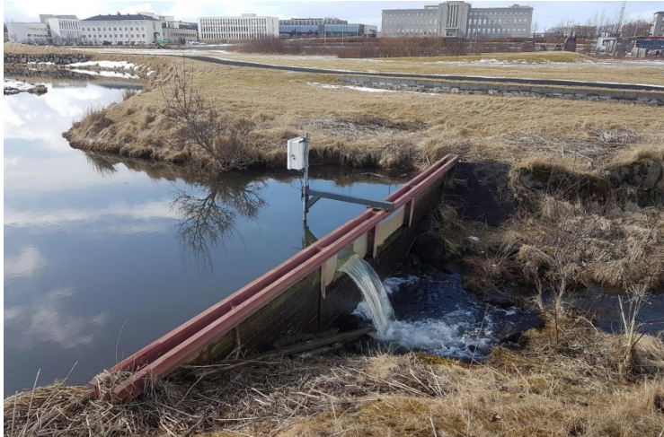
Mynd 3 Yfirfall sem er útrás Vatnsmýrarinnar yfir í Tjörnina og stýrir vatnshæð í Vatnsmýrinni.
