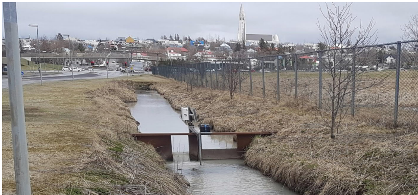
Mynd 2 Yfirfall í skurði við Njarðargötu við innrennsli í Vatnsmýrina sem stýrir vatnshæð og rennsli.
