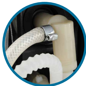
A szivattyú és a kazán között
